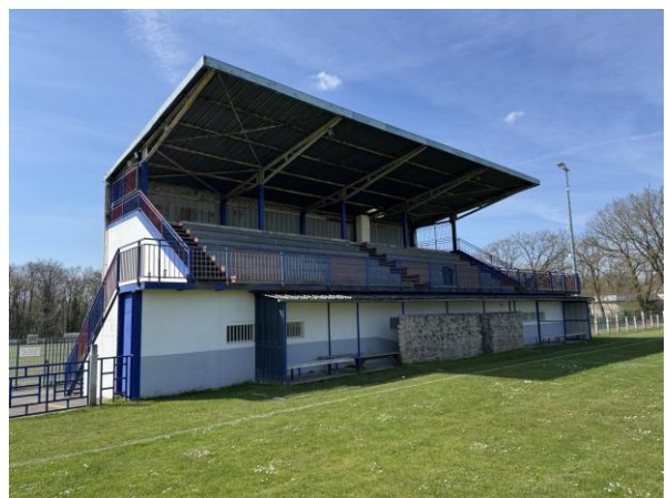
Vue générale du bâtiment et de la tribune depuis le terrain
