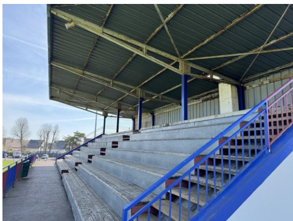
Gradins et charpente de la tribune existante
